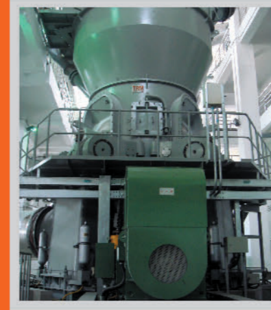
TRM122.3 辊渣立磨 浙江玉环电厂 - 2007 年
