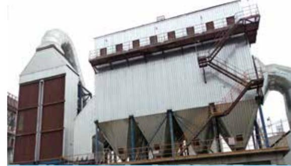
中材汉江窑头袋除尘及空气冷却器 (2500t/d)
