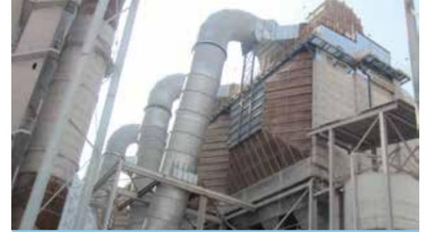
沙特 SCC 水泥生产线 (5000t/d) 水泥磨袋除尘器改造
