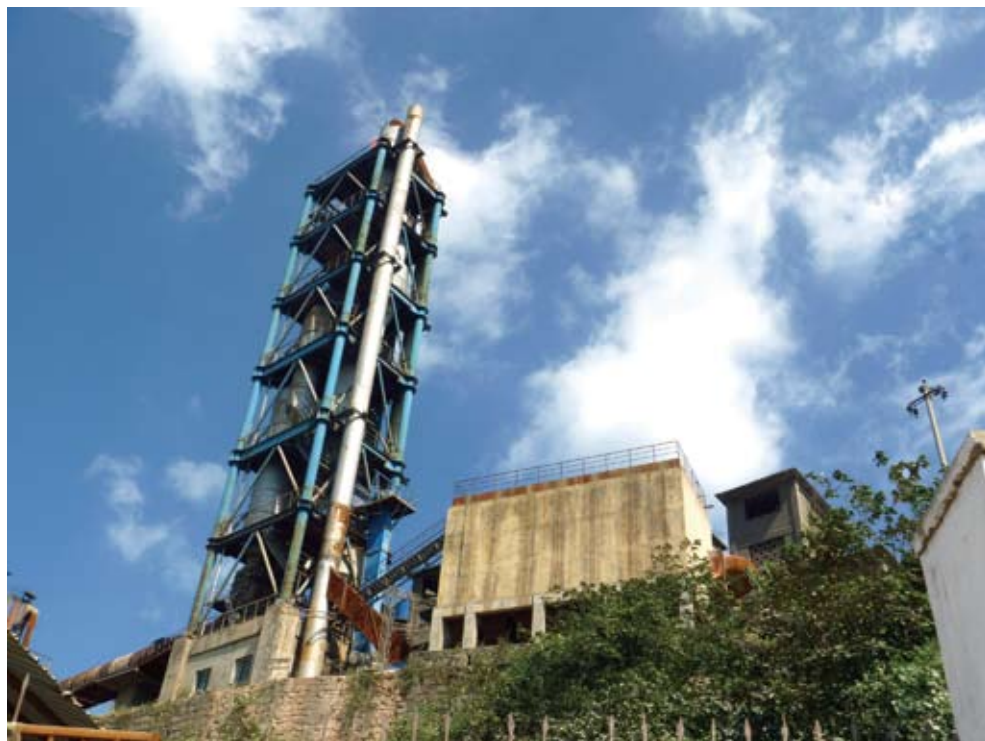
现有的硫铝酸盐水泥厂概貌 Existing Sulphoaluminate Cement Production Line
