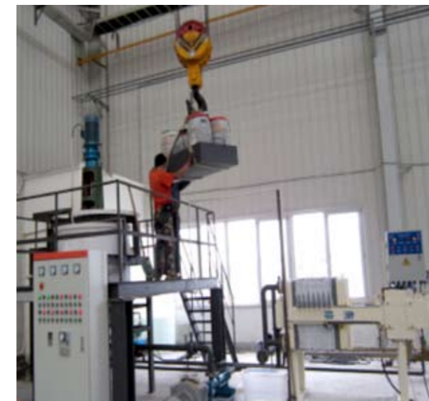
污泥深度脱水试验平台 sludge deep dehydration testing platform
