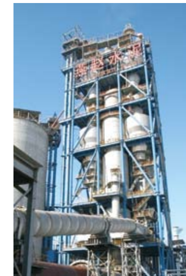
河北燕赵水泥公司分级燃烧脱硝系统 Hebei Yanzhao Cement Co.,Ltd air staged combustion denitration system
