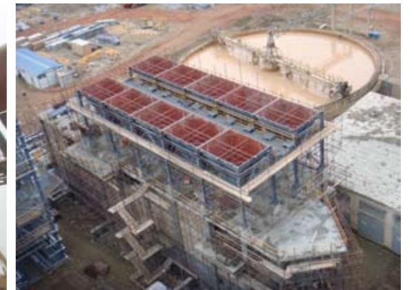
▲ 窑尾收尘器 Kiln inlet dust collector
