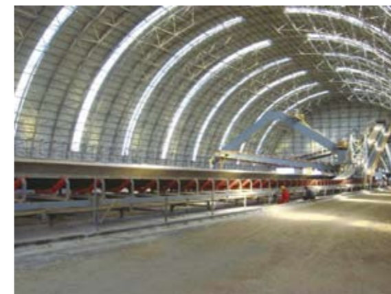
▲ 原料库建设 Construction of raw material silo
