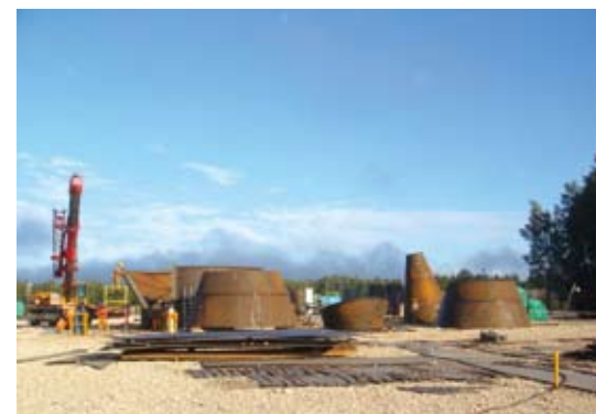
▲ 现场制作 On-site production
